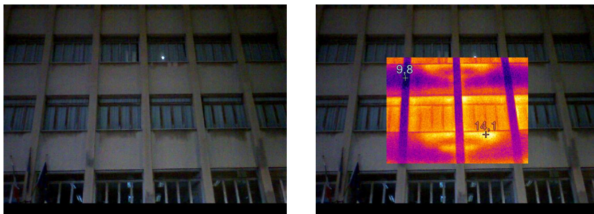
Figura 4.3 – Rilievo termografico della parete
