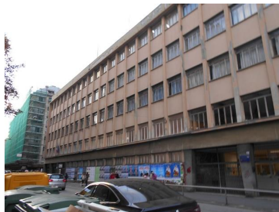
Figura 0.1 - Vista della facciata [esposta a Sud-Est]
