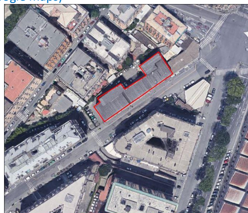
Figura 2.2 - Vista satellitare dell’edificio (Fonte: Google maps)
