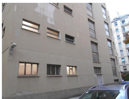
Figura 8.1 - Particolare di una parete esterna
