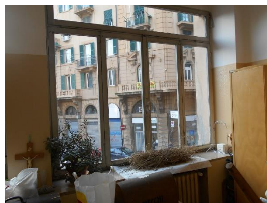
Figura 8.5 - Particolare di un infisso
